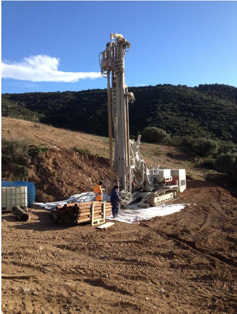
Figura 10 – Ubicazione del punto di perforazione del piezometro R4
