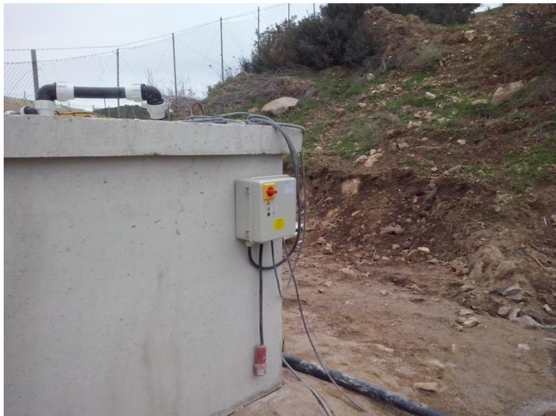
Figura 11 – Serbatoio da 2.00 litri su cui convergono le acque di spurgo dei due piezometri
